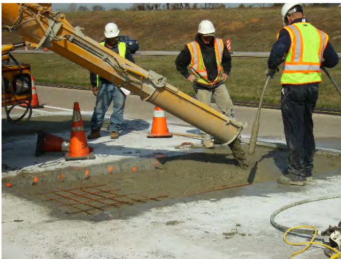
Pouring New Concrete
