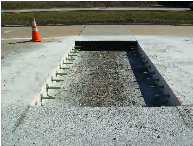
Replacement Section Prepped For Pour
